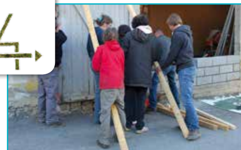
Moment de chantier lors d'Habitez-là
